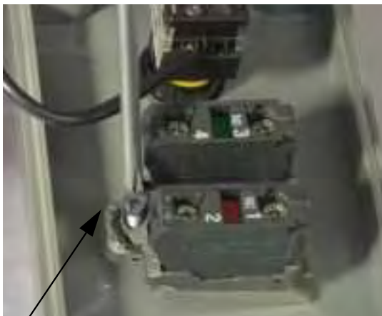
Tornillo del cuerpo del interruptor
