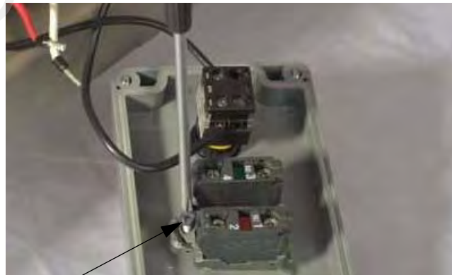
Tornillo del cuerpo del interruptor
