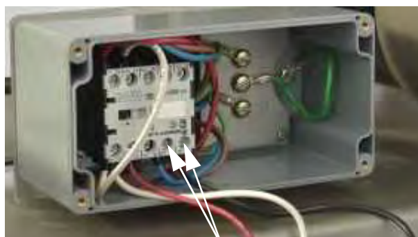
Vis de fixation
